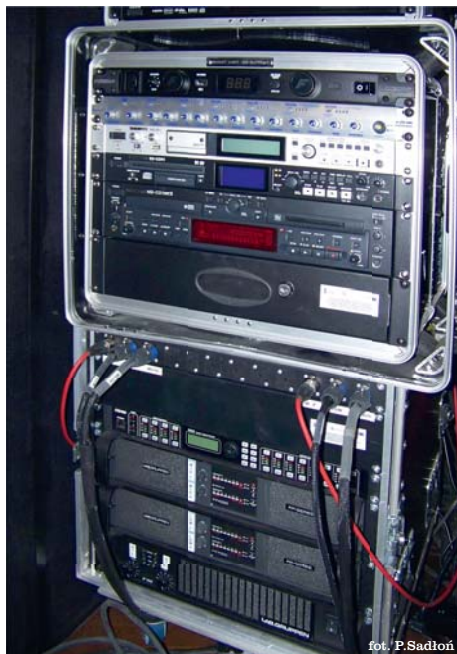
System nagłośnieniowy Sali Kameralnej napędzany jest ze wzmacniaczy Lab Gruppen FP4000, FP7000 oraz iP900 i sterowany z procesora EAW UX8800.
